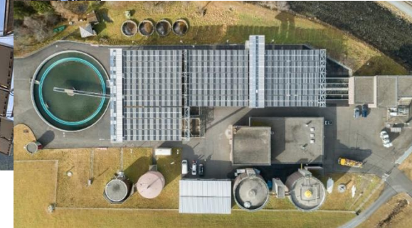
Beispiel: solares Faltdach für die Kläranlage Davos
