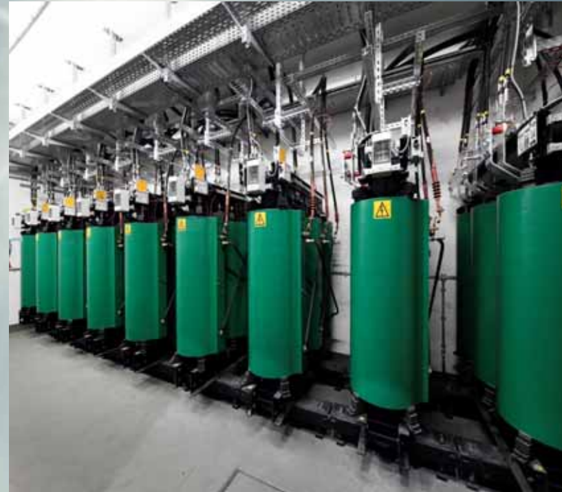
9 AC/AC Leistungstransformatoren 0,5 kV / 20 kV – 1 MW
